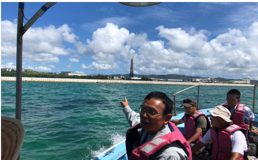
辺野古護岸工事の様子 2018. 8. 18
